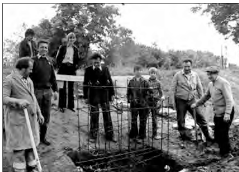
131. Budowa kładki nad Rokitnicą
