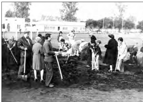
130. Przy budowie stadionu
